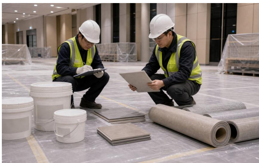
图 1-10 地面材料铺设准备（现场实景）
