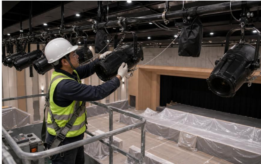
图 1-6 舞台灯光设备安装（现场实景）
