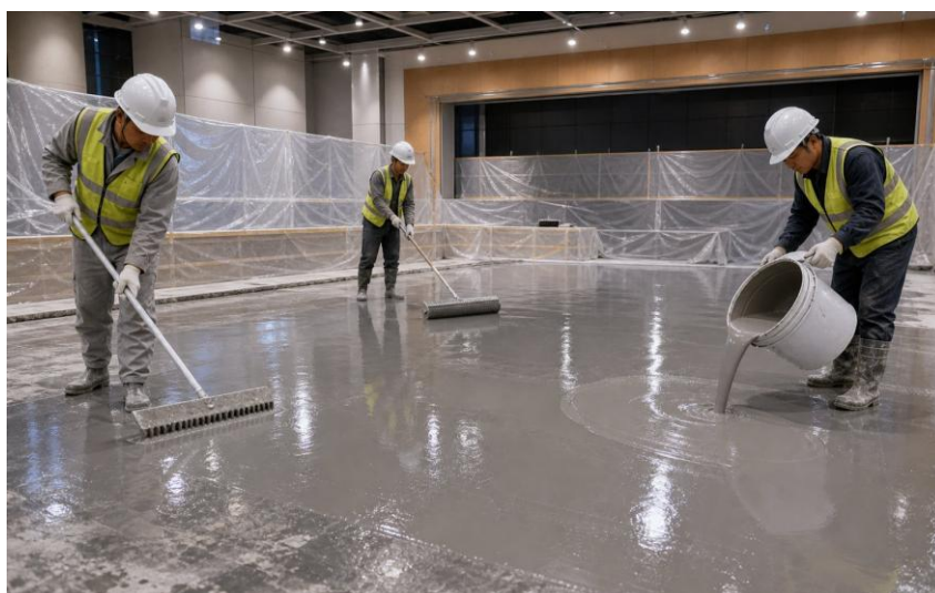
图 1-4 地面水泥自流平施工（现场实景）
