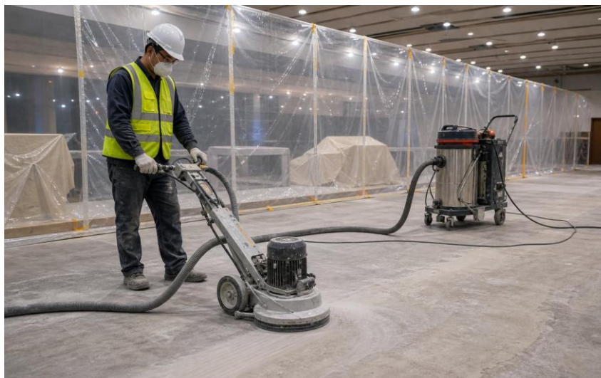
图 1-3 地面打磨抛光（现场实景）
