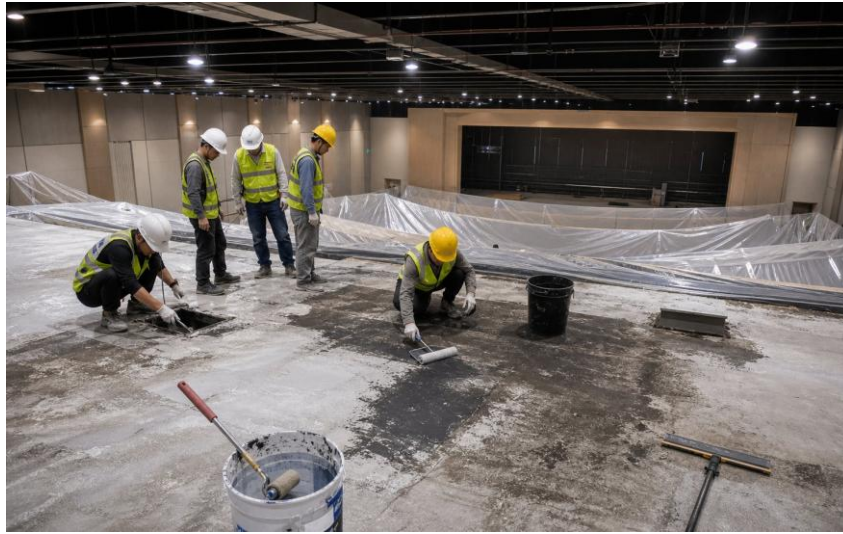
图 1-1 地面找平施工（现场实景）
