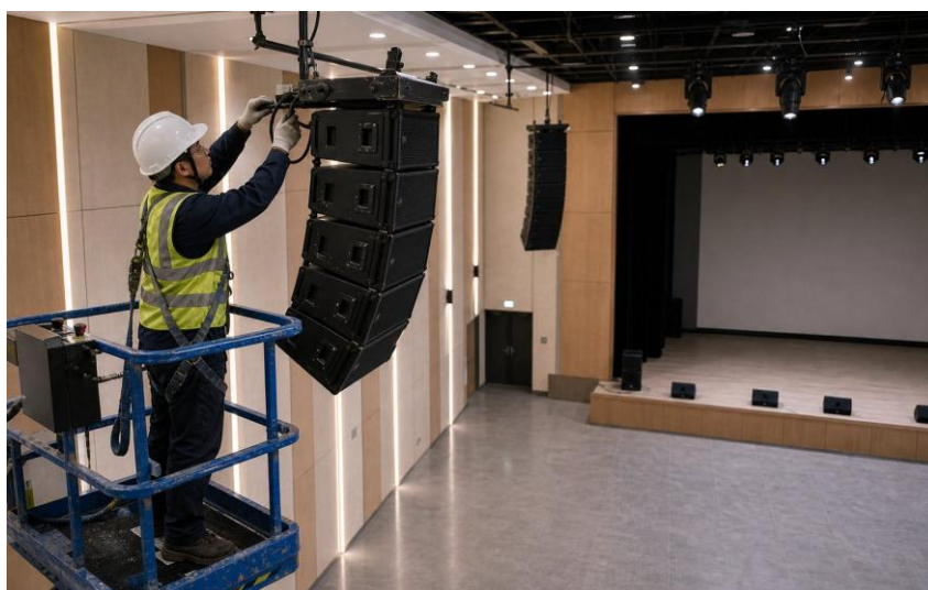
图 1-14 舞台灯光设备安装（2）（现场实景）
